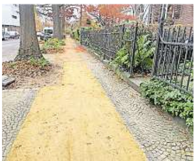
So sieht der Bürgersteig an der Roonstraße jetzt aus. Das historische Pflaster ist einer „wassergebundenen Wegdecke“ gewichen.
